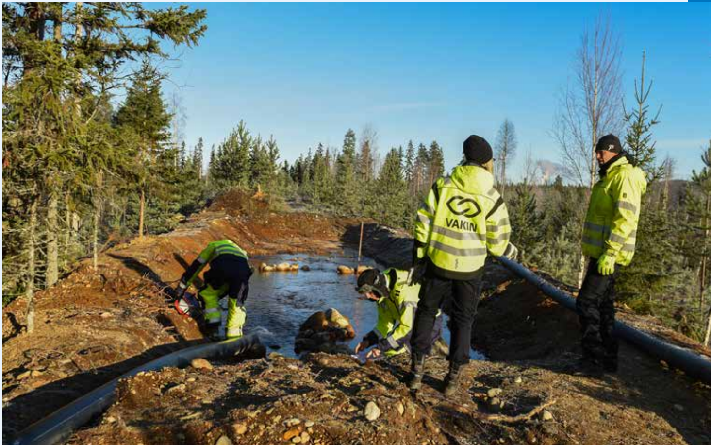
Provpumpning, en del i förstudien för en ny vattentäkt.
